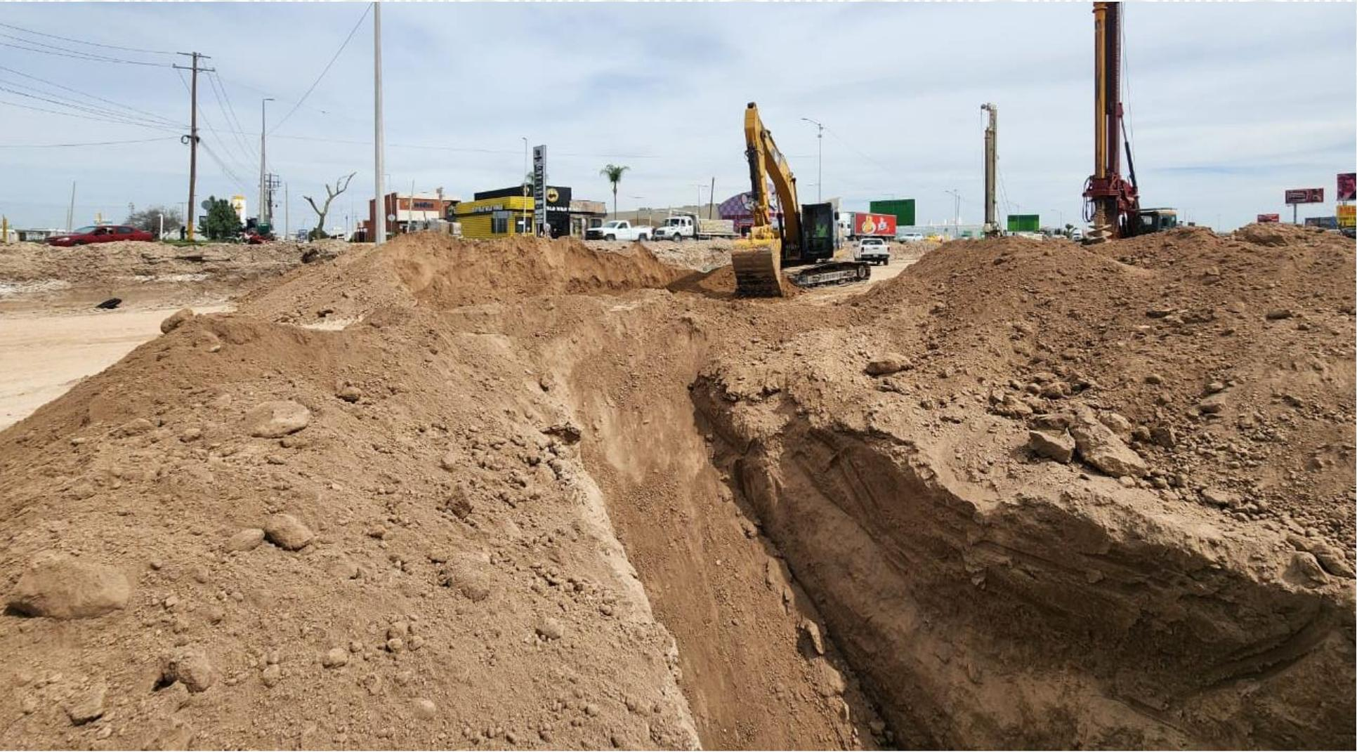
Se realiza sondeo por medios mecánicos para descubrir tubo de acero de ecogas, se protege excavación con material producto de esta.
