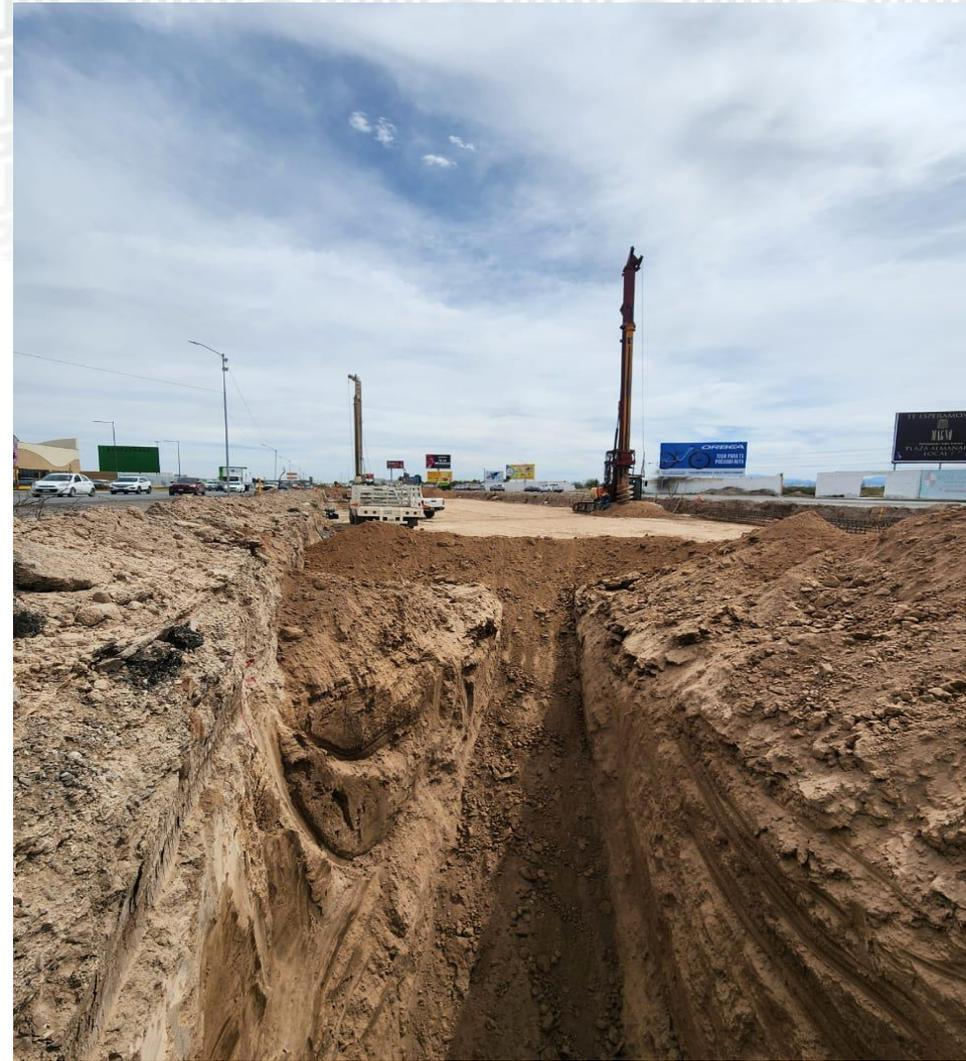
Se realiza sondeo por medios mecánicos para descubrir tubo de acero de ecogas, se protege excavación con material producto de esta.
